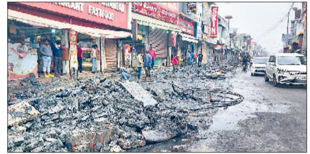
झज्जर। अंबेडकर चौक पर नाला सफाई कार्य में जुटे कर्मचारी व सड़क पर पड़ी नाले से निकाली गई गंदगी।
